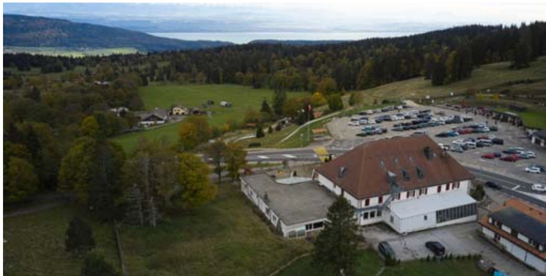
L'hôtel de La Vue-des-Alpes photographié ici avant le début des travaux, en décembre 2023.
